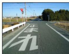
交差点リフレッシュ 道路法定外表示 (止まれ)設置
